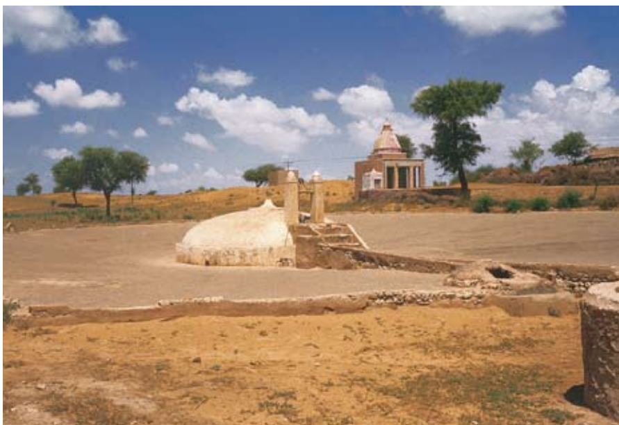
Système traditionnel de récupération de l'eau de pluie appelé Kundi au Rajasthan
